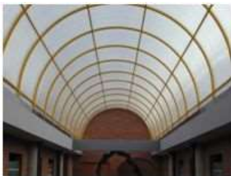
Рис. 4 а – Світлопрозорі покрівлі
