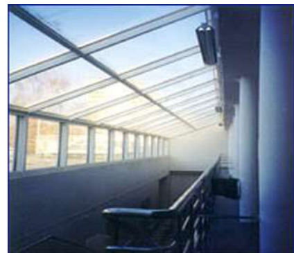
Рис.4 б – Світлопрозорі покрівлі
