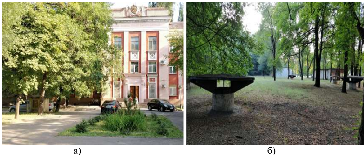
Рис. 1. а) про вбудоване сховище під будівлею можна здогадатися лише по вентиляційній шахті зліва; б) окремо стояче сховище; на фото можна побачити вентиляційні шахти та входи/виходи на задньому плані.
