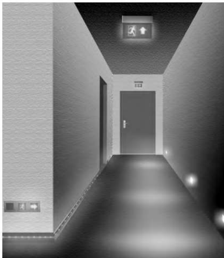
Рис.1. Підсвітка коридорів під час пожежі в будівлі
