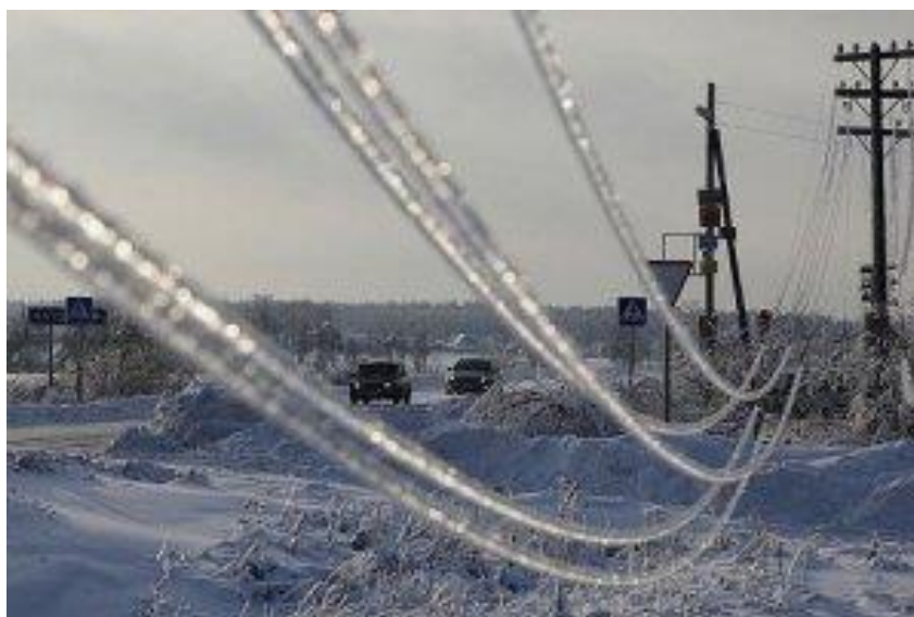
Рис. 1. Ожеледь на лінії 10 кВ
