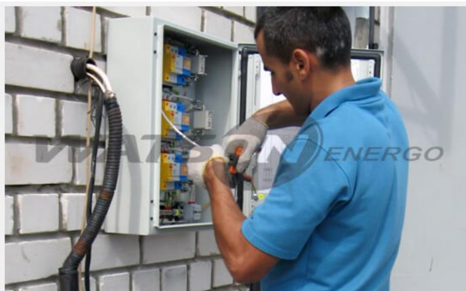
Рис. 3. Монтажна зборка внутрішнього блискавкозахист приватного будинку
