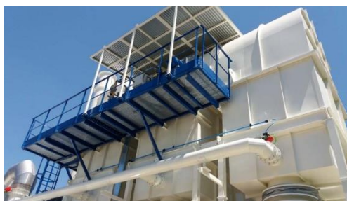
Рис. 1. Установа очищення газів (RTO) поліграфічного підприємства
